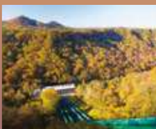
王子製紙 千歲第一發電廠
